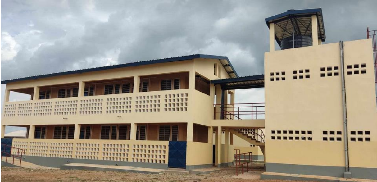
Figure 15: Un dortoir à deux niveaux et deux façades, avec des chambres pour les filles (rez-de-chaussée) et les garçons (à l'étage) à gauche, et les douches et toilettes, pour les deux sexes à droite
