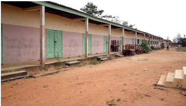
2 e bloc de salles du lycée
