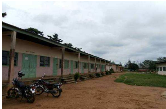
Bloc de salles du lycée
